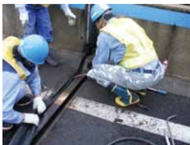
新規シールゴム組込状況
