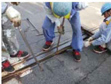
既設シールゴム取外し状況 (片側車線を通行止め、路面上より作業)
